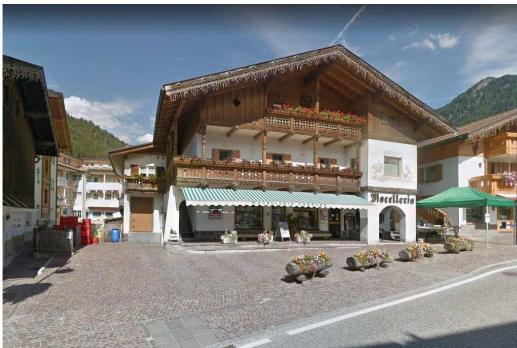
P. ed. 566 in C.C. Pozza – Poza – vista da Strada de Meida
